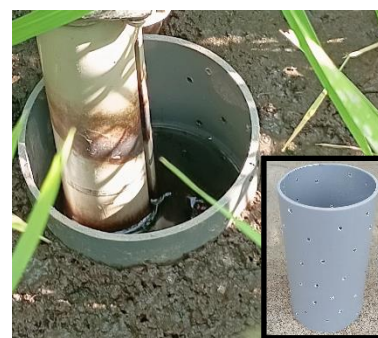
図3 水位センサーと塩ビ管の設置状況
